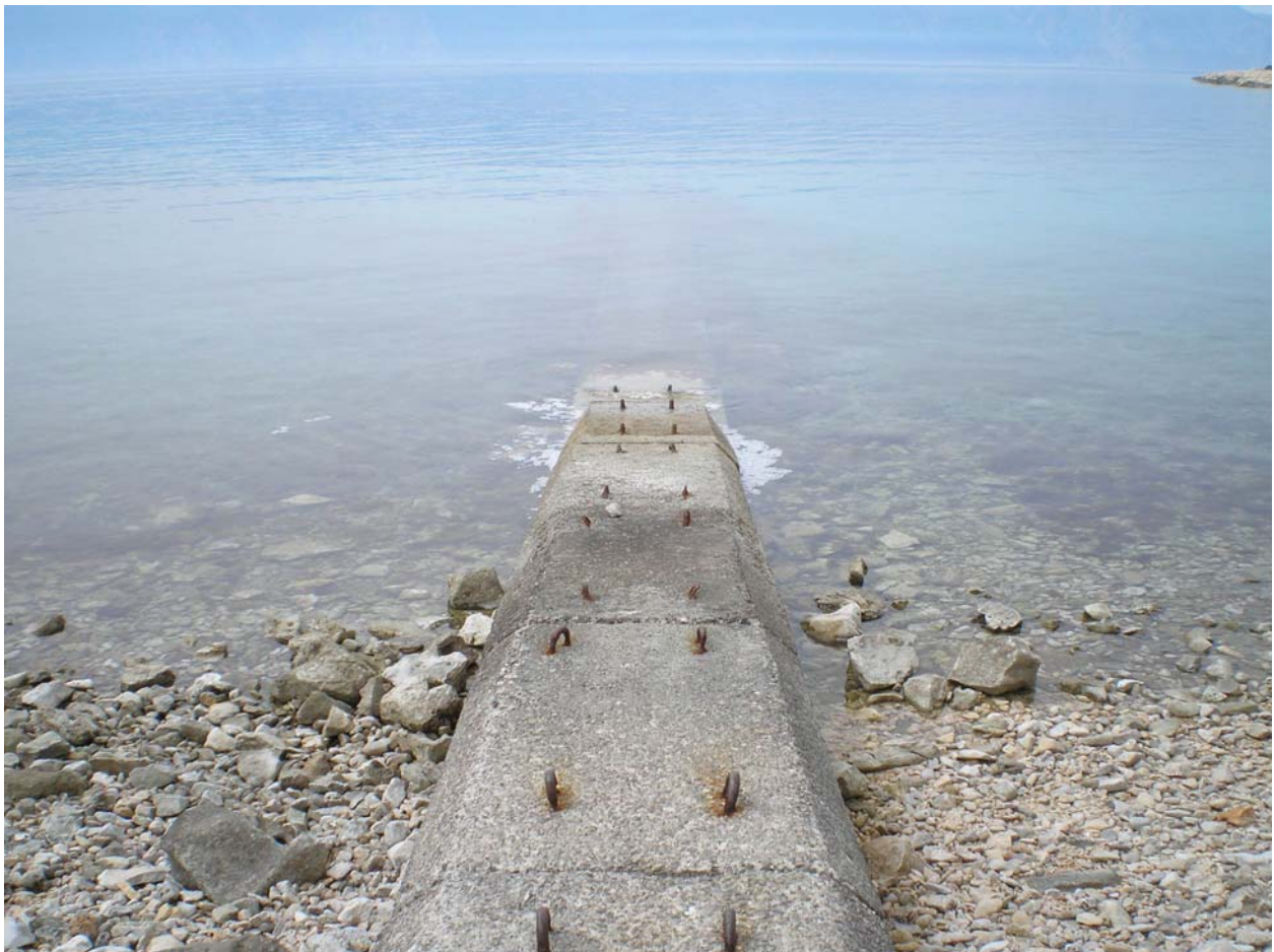
Slika 1. Klasična priobalna zaštita 110 kV podmorskog kabela
