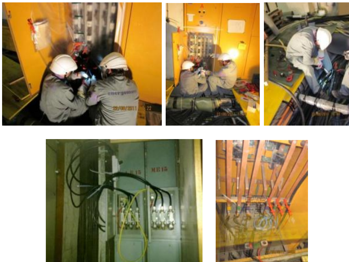
Slika 3. Zbirka fotografija RPN na NN – novo vezivanje vertikalnih NN vodova snage u UKCLJ [15]
