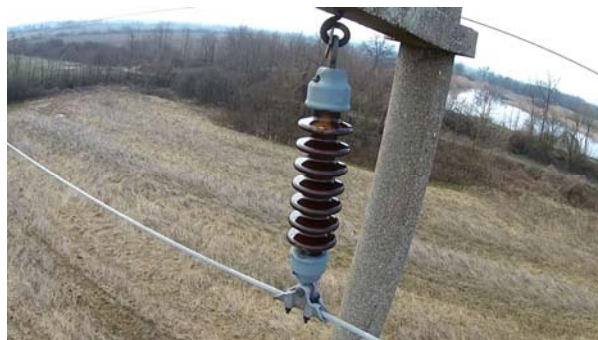
Slika 8. Oštećenje 35 kV porculanskih izolatora uzrokovano atmosferskim pražnjenjem
