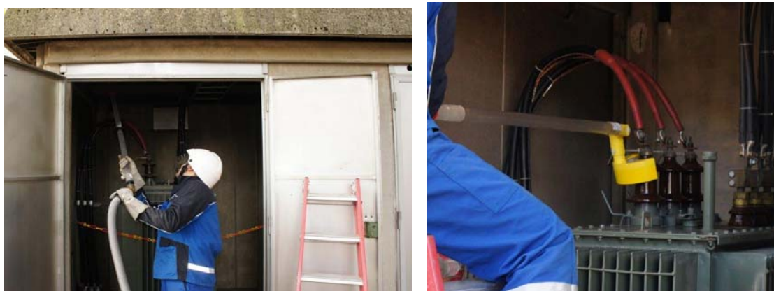
Slika 4. Čišćenje TP Očesna klinika – metoda RPN na SN na udaljenosti (Izvor EL)
