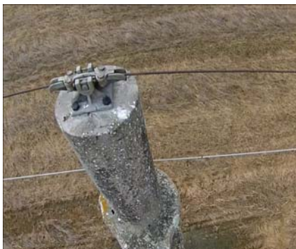
Slika 9. Detalj krune betonskog 35 kV stupa s nosnom stezaljkom zaštitnog užeta
