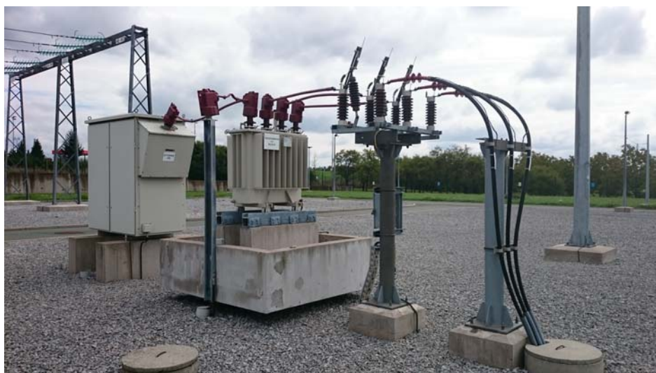
Slika 4. Postrojenje za uzemljenje zvjezdišta mreže 10(20) kV
