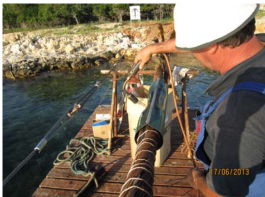
Slika 5. Izrada spojnice na splavi
