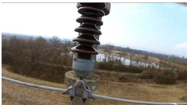
Slika 8. Oštećenje 35 kV porculanskih izolatora uzrokovano atmosferskim pražnjenjem
