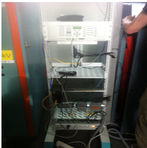
Slika 5. SV prema IEC 61850, poglavlje 9-2, TS VELIKA GORICA
