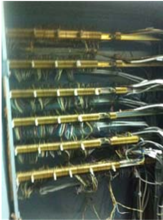
Slika 1. Signalni kabeli u TS EL-TO, slikano tijekom rekonstrukcije
