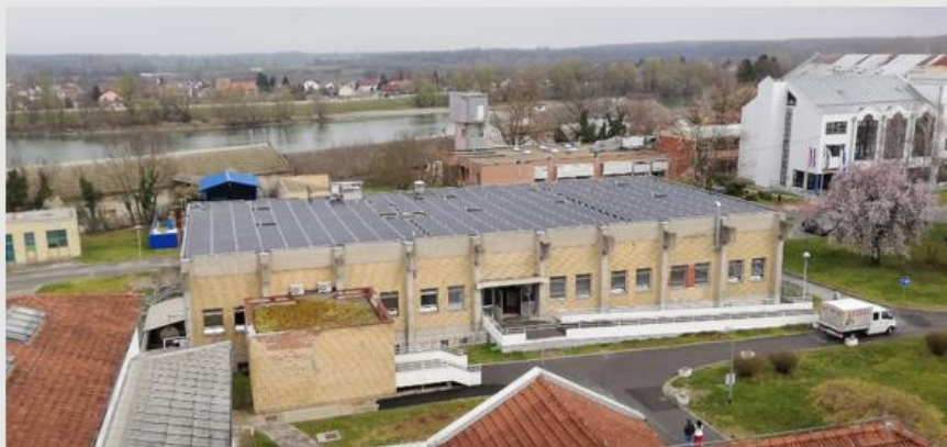
FNE KBCO 1 (110 kW) (Zgrada prehrane)
