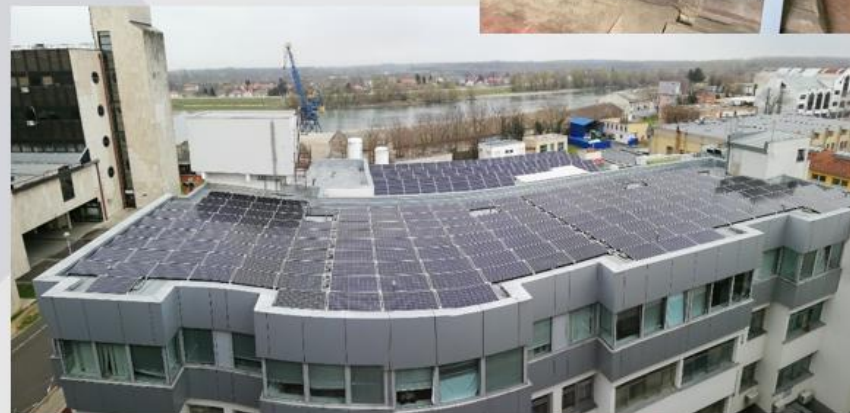
FNE KBCO 2 (120 kW) (Zgrada Onkologije i Radiologije)
