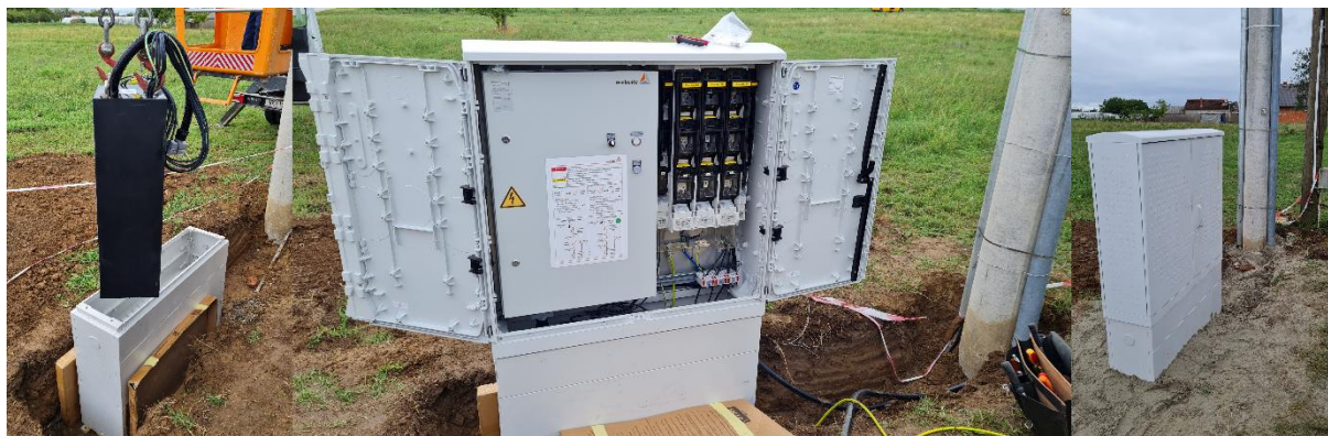
Slika 6. Prikaz ugradnje regulatora napona na povoljnoj lokaciji
