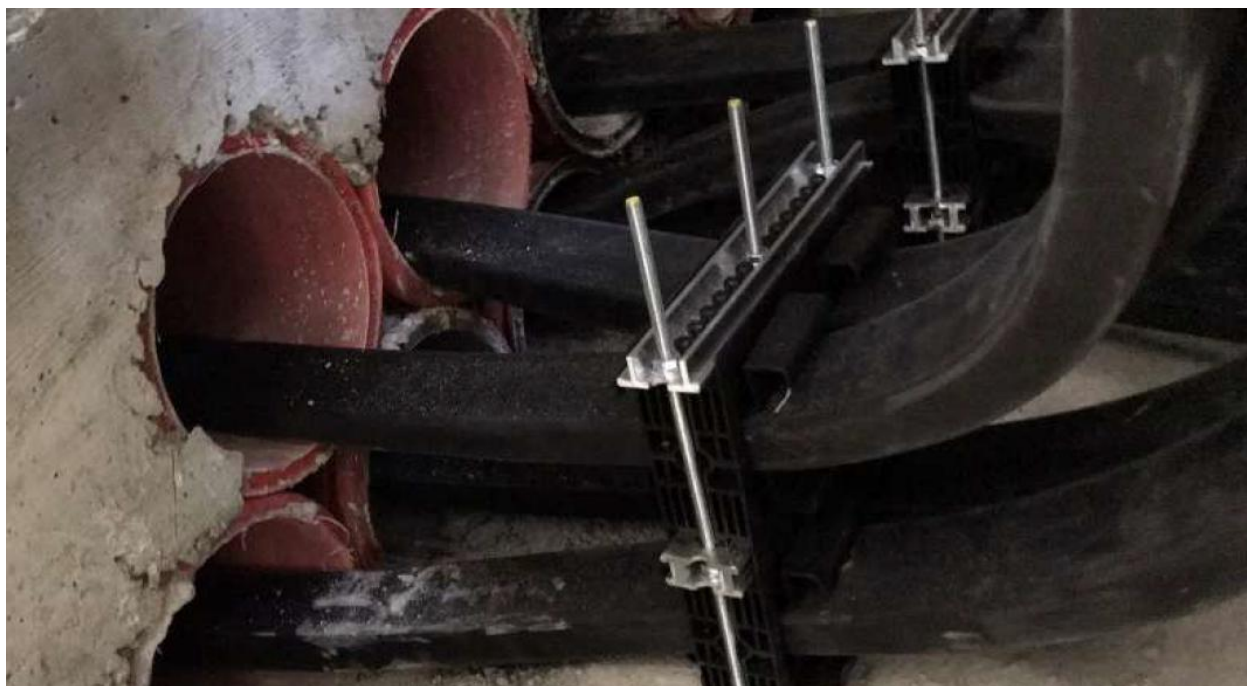
Slika 30. Sustav izoliranih fleksibilnih sabirnica - ugradnja u cijevi
