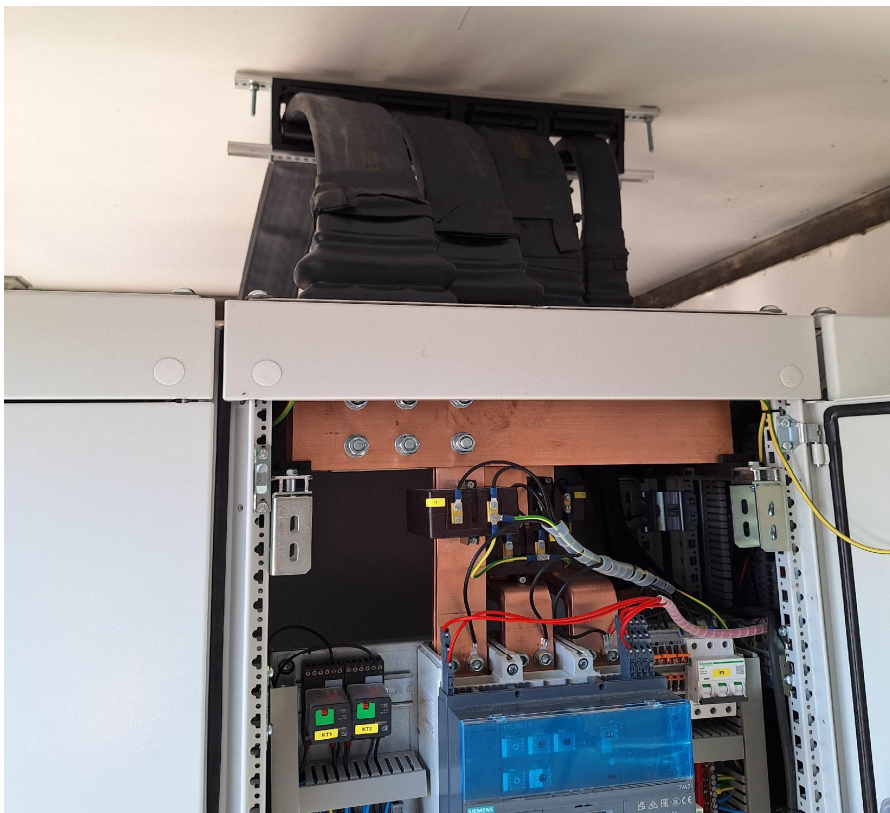
Slika 32. Spoj Flexbus sabirnica na niskonaponski sklopni blok - prednji pogled
