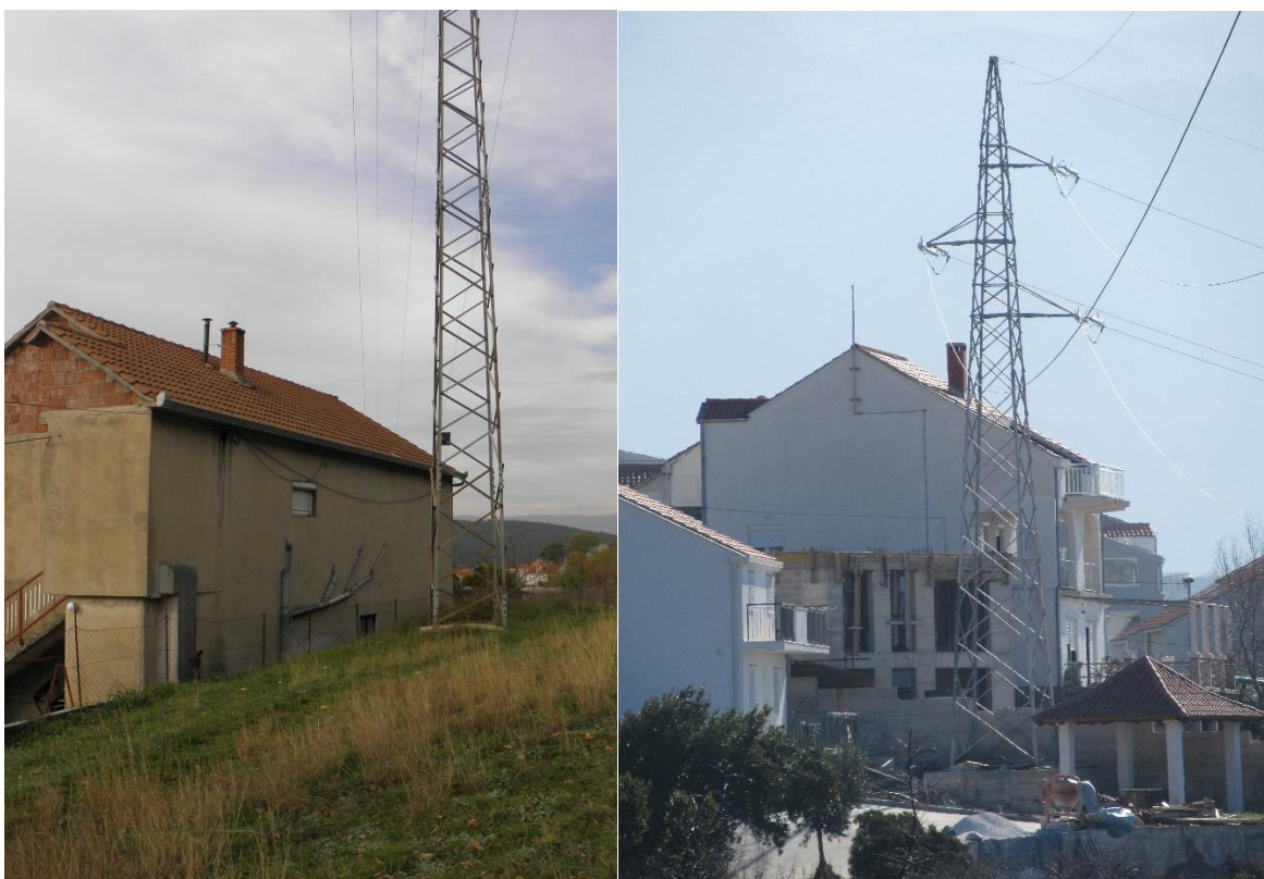
Slika 7: Primjeri prelaska dalekovoda preko kuća
