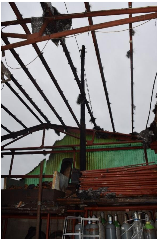
Slika 1: električni stup i priključni kabel
