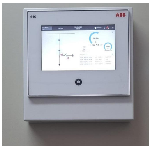
Slika 5.: Zaštitni relej vodnog polja 20kv, ABB RX640
