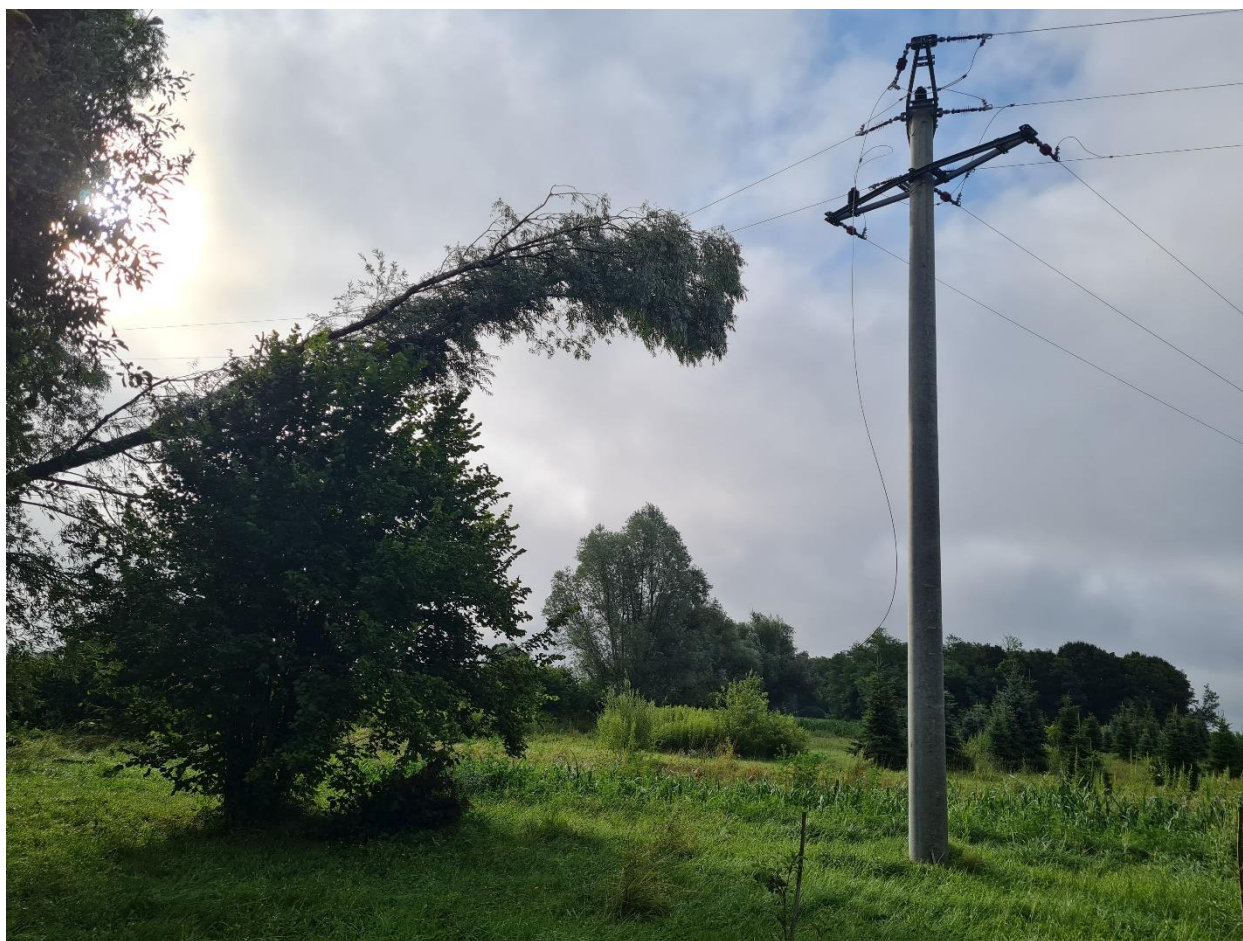
Slika 1. Primjer kvara nakon nevremena koji može prouzrokovati višepolni kratki spoj
