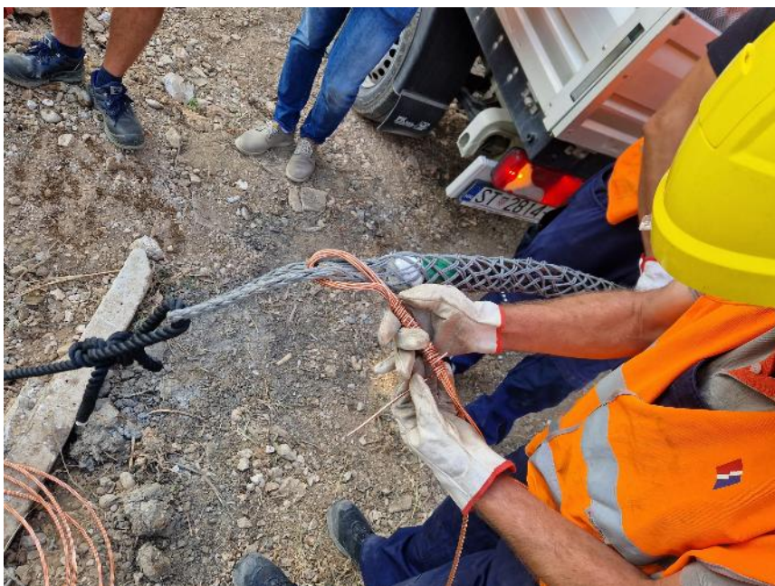
Slika 11. Detalj povezivanja bakrenog užeta i kabela na užu za povlačenje
