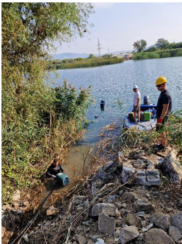
Slika 12. Ronilac povezuje plutače na početku kabela
