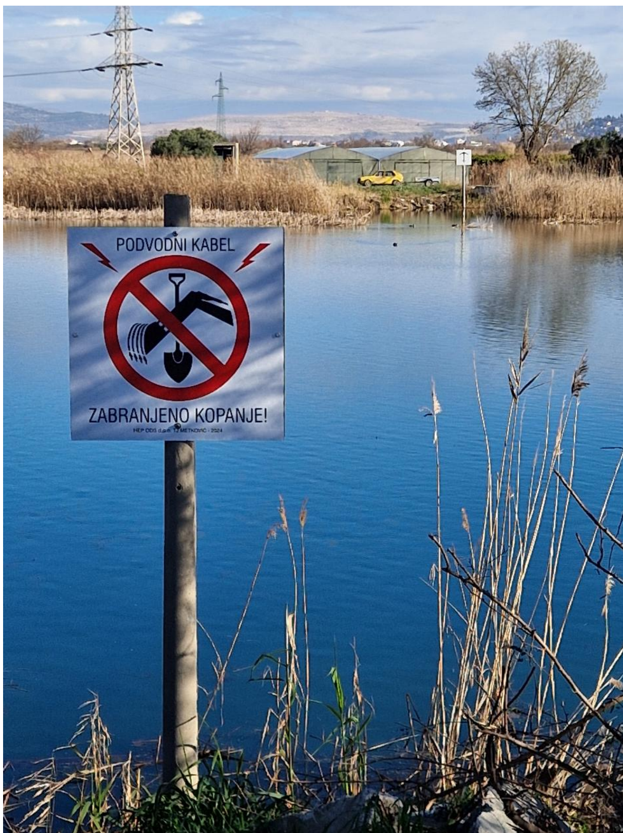
Slika 18. Označavanje trase kabela. Znak "Zabranjeno kopanje" usmjeren prema obali, a znak "Zabranjeno sidrenje" okrenut prema plovnom putu.
