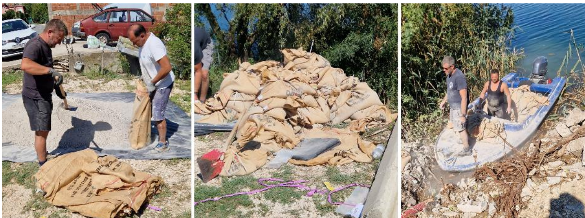
Slika 16. Proces punjenja i transporta vreća punjenih suhim betonom
