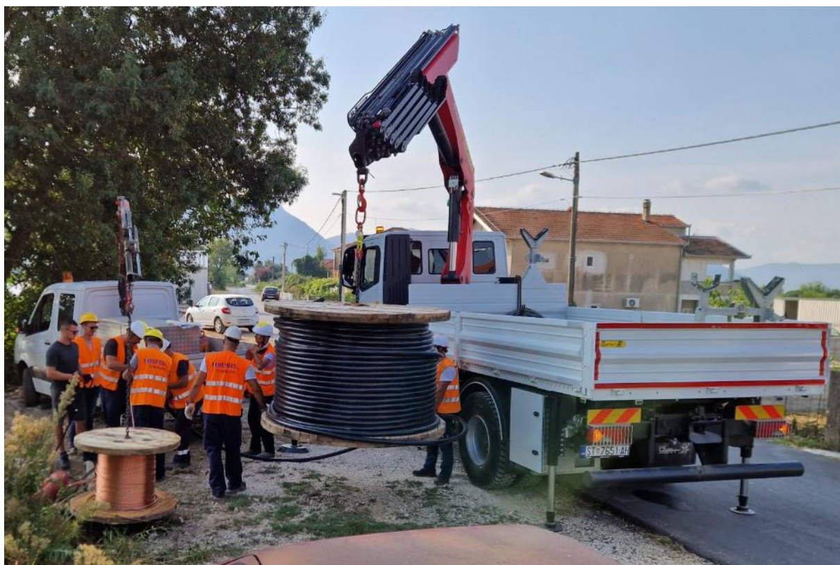
Slika 14. Radnici TJ Metković istovremeno puštaju kabel i bakreno užje uz pomoć dizalica
