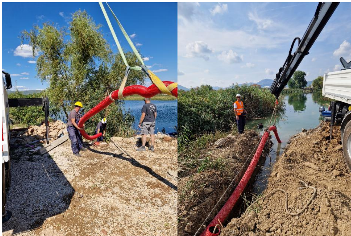
Slika 17. Postavljanje priobalne zaštite na južnoj obali (lijevo) i sjevernoj obali (desno)
