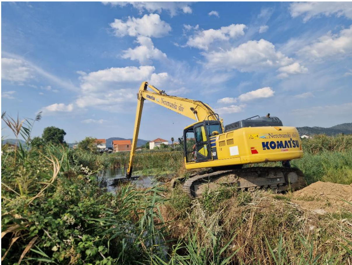
Slika 9. Bager sa radijusom dohvata 18 m
