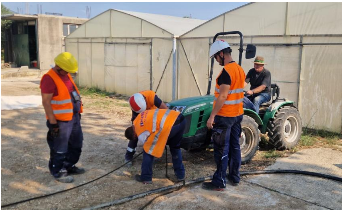
Slika 13. Povlačenje kabela traktorom
