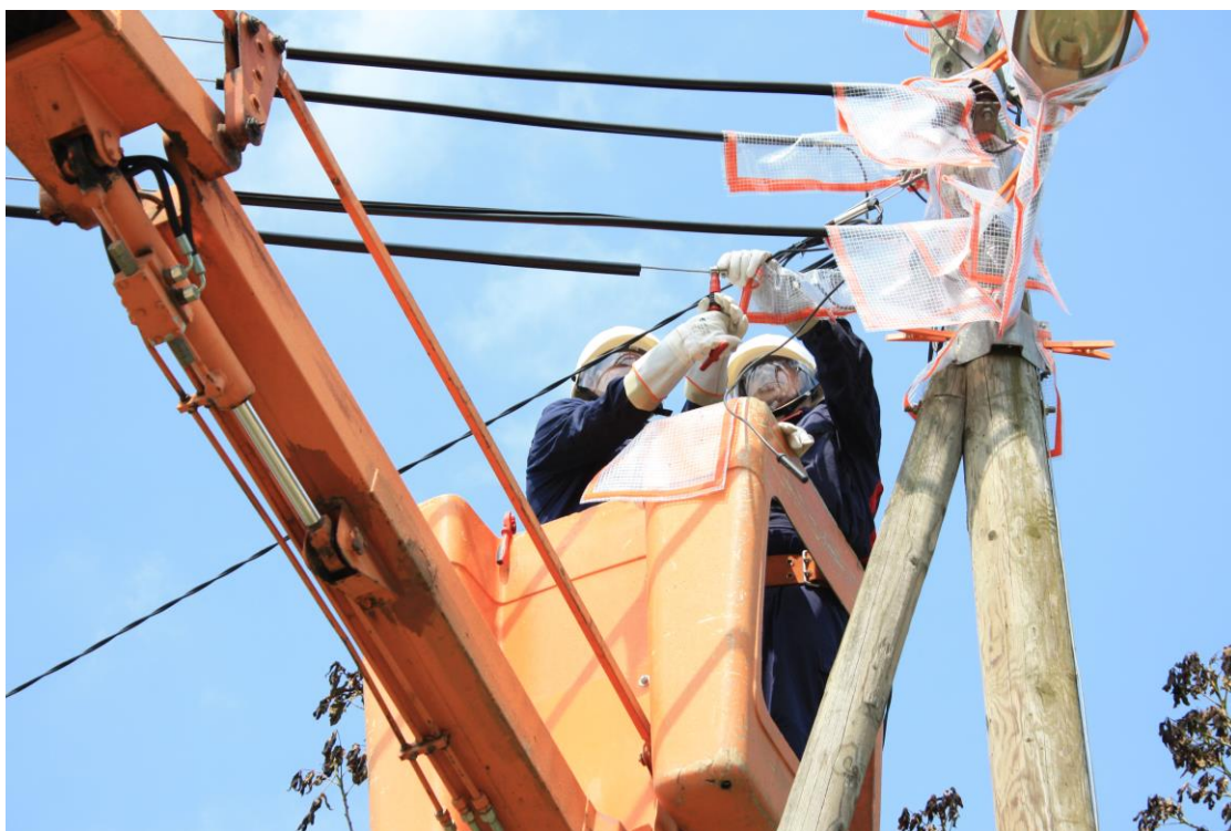
Slika 1. Priprema radova i rad pod naponom radnika Elektre Bjelovar
