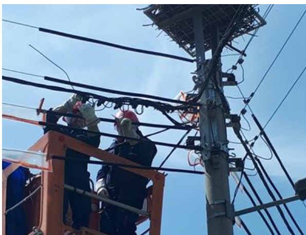
Slika 6. Primjena tehnike rada pod naponom na niskonaponskoj mreži
