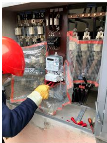
Slika 5: Primjena tehnike rada pod naponom
