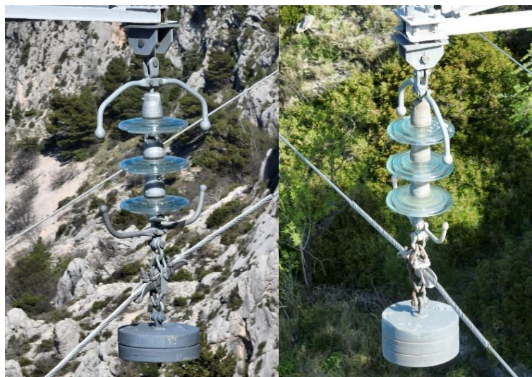
Slika 5. Stanje nakon sanacije
