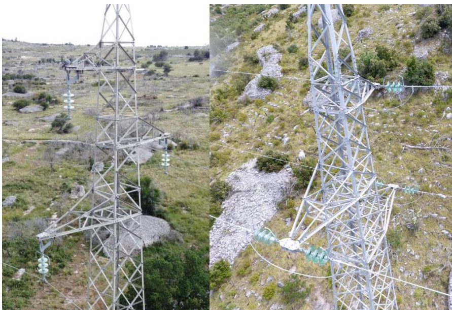
Slika 9. Novi izolatorski lanci sa zaštitnim rogovima umjesto iskrišta
