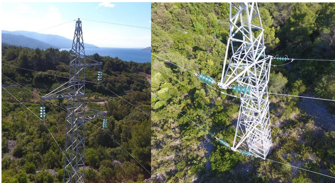
Slika 10. Nosni i zatezni stup nakon obnove
