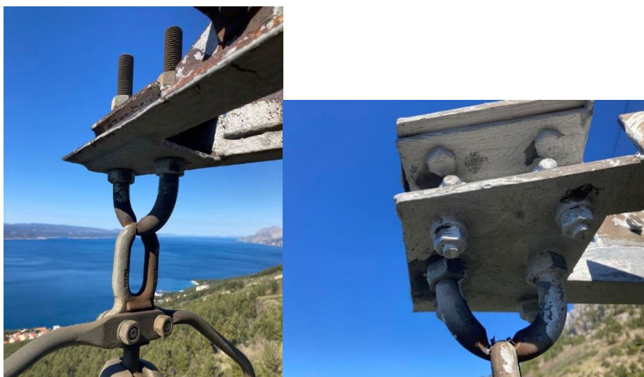
Slika 3. Istrošenost stremena i karike – dva tipa konzole
