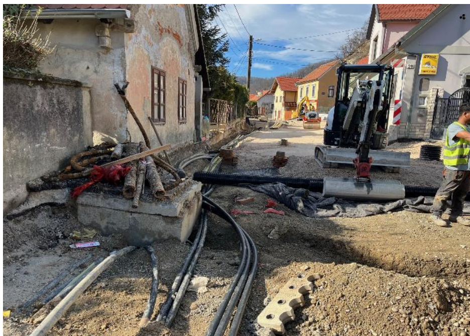
Slika 4. Stanje na terenu pri rekonstrukciji
