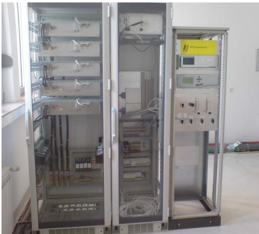
Slika 8. DC/AC pretvarači i upravljanje
