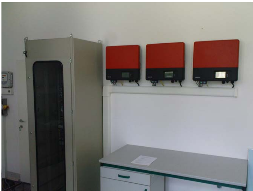
Slika 5. Upravljački ormar i pretvarači fotonaponske elektrane
