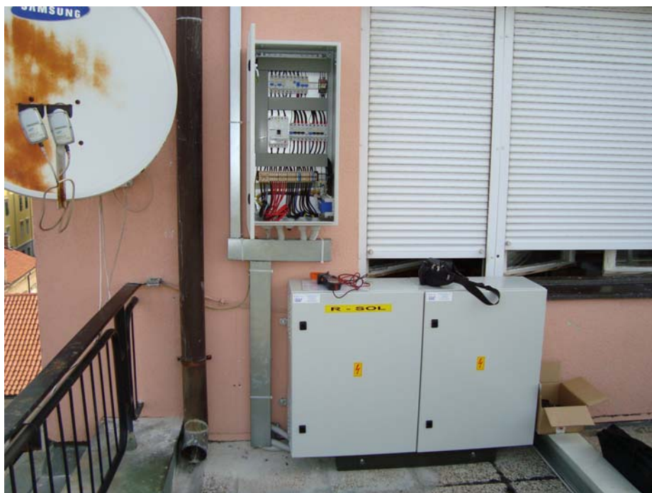
Slika 4. Razvodni ormari i invertori smješteni su pored samih solarnih panela
