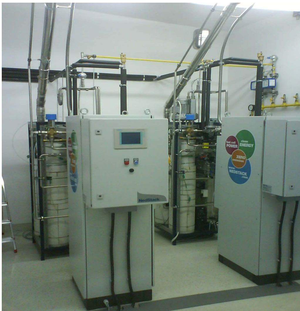
Slika 7. Reformeri i gorivni svežnjevi
